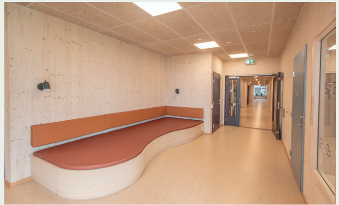
Innvendige vegger og dekker er i massivtre.
