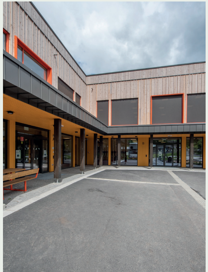
Omtrent halvparten av ytterveggene i det nye skolebygget er i massivtre, og halvparten er plassbygde. Alt er kledd i malmfuru.
